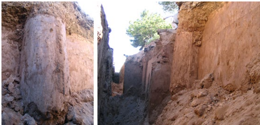
شکل ۶. شناسایی بقایای معماری در حین گودبرداری در خیابان حکیم نزاری
